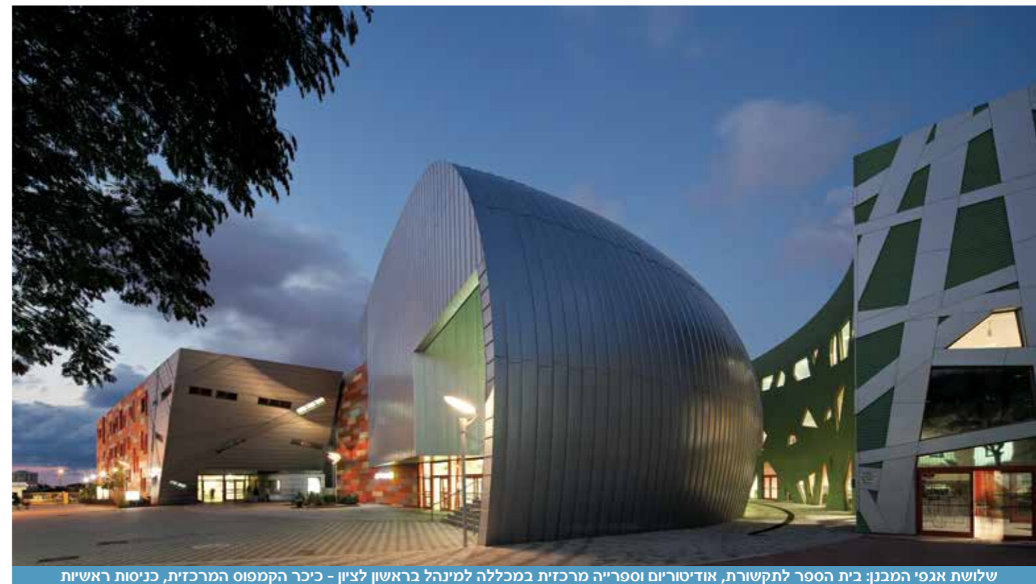
שלושת אגפי המבנים: בית הספר לתקשורת, אודיטוריום וספרייה מרכזית במכללה למינהל בראשון לציון - כיכר הקמפוס המרכזית, כניסות ראשיות
